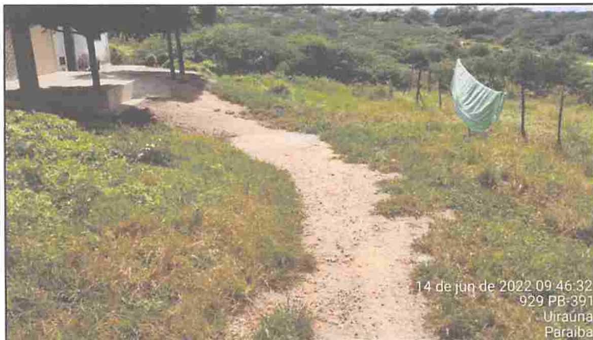
Imagem 07: Rua Projetada - autoria própria
