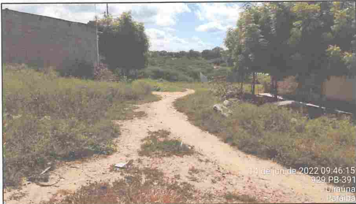
Imagem 04: Rua Projetada - autoria própria
