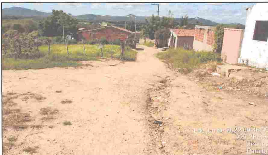
Imagem 05: Rua Projetada - autoria própria
