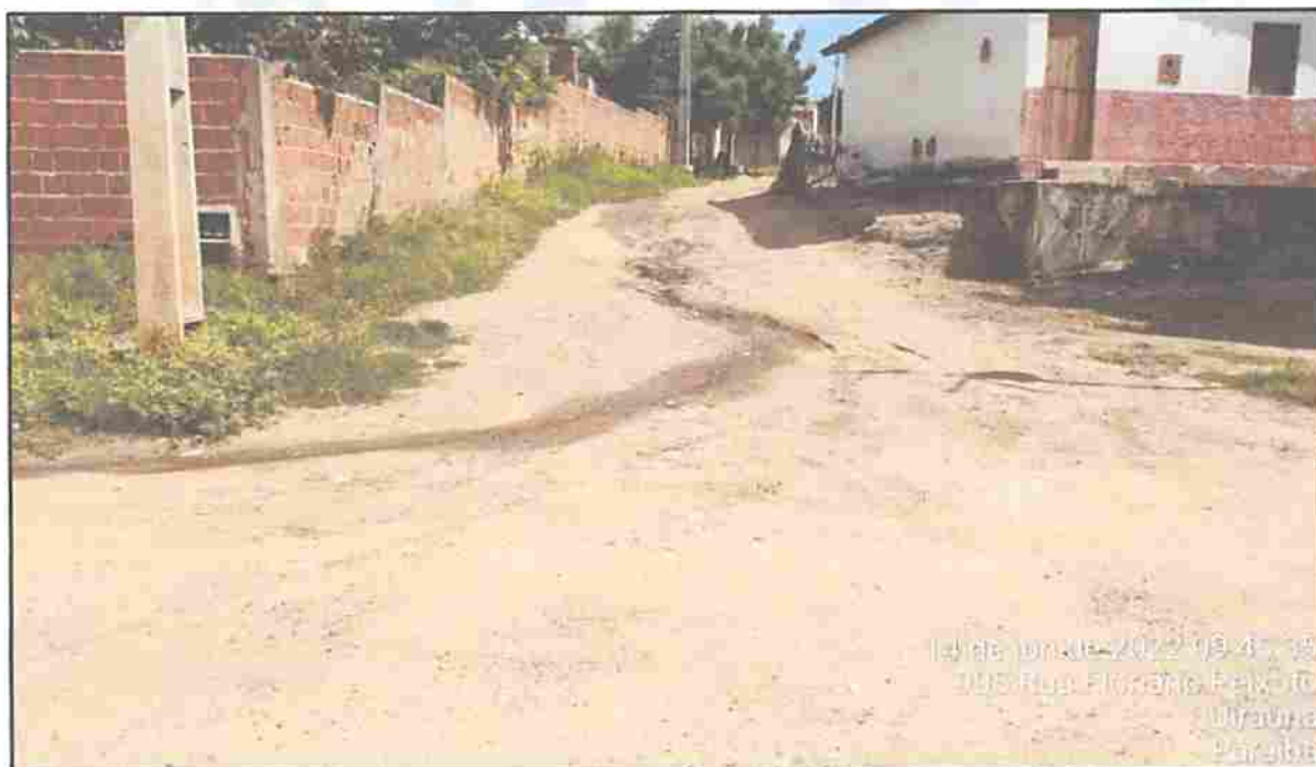
Imagem 08: Rua Projetada - autoria própria
