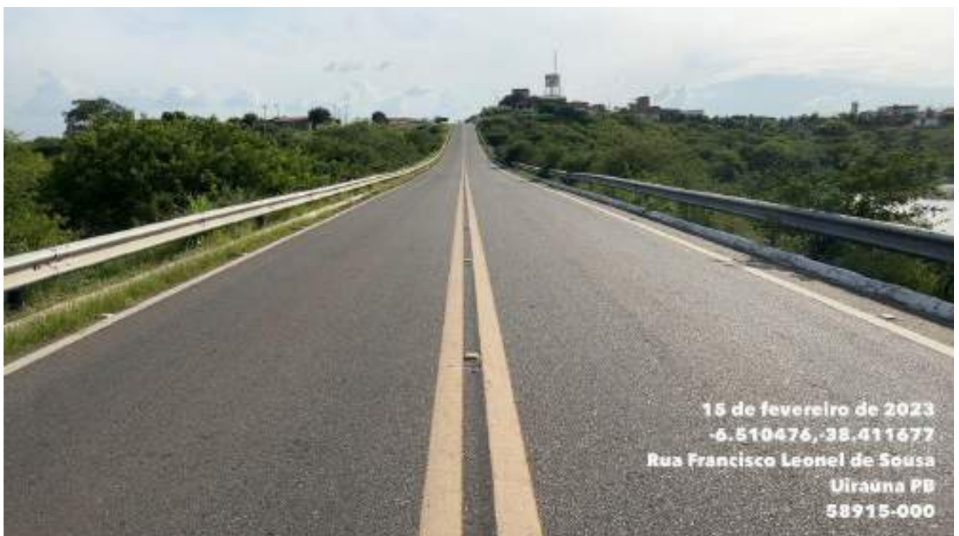
Captação do Sistema Canadá na BR 405.
