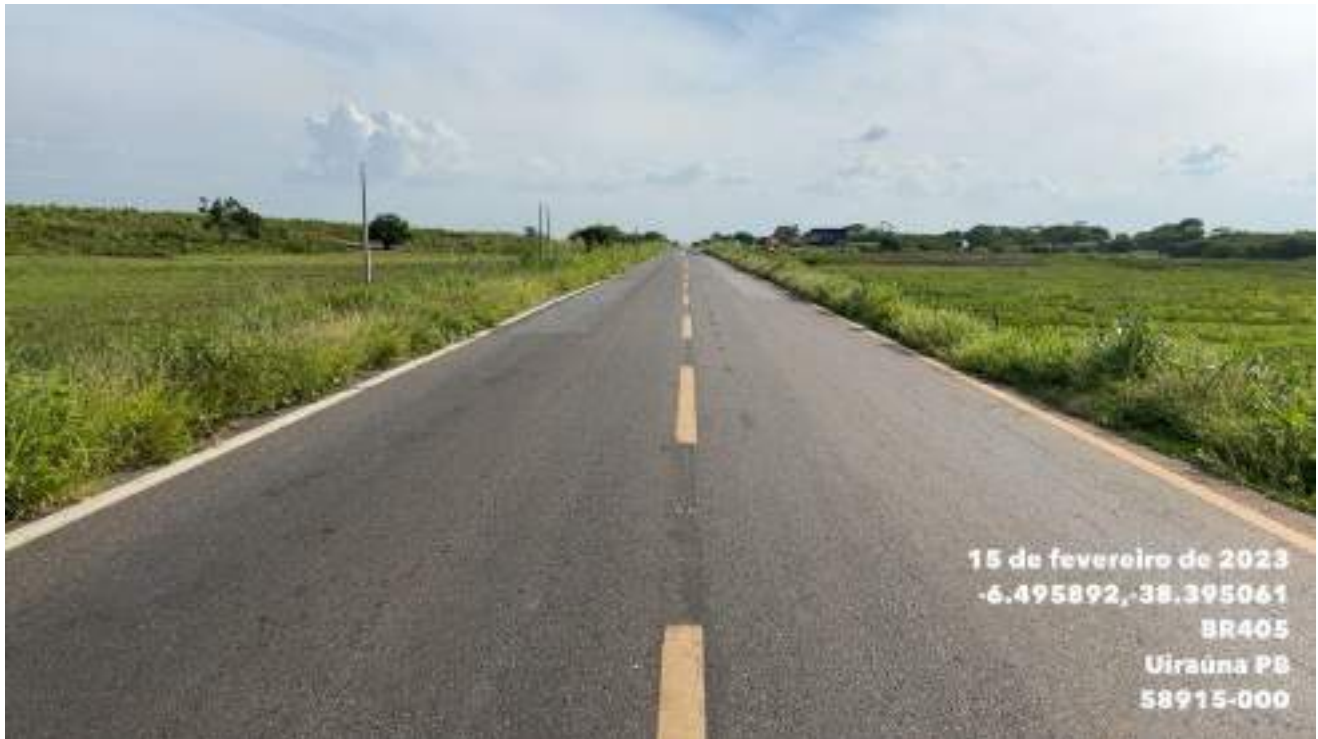
Passagem do Abastecimento vindo da Captação do Canadá para o Sistema Elevatório.
